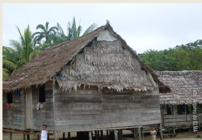
Casa de madeira e palha em comunidade ribeirinha sem acesso a rede elétrica
