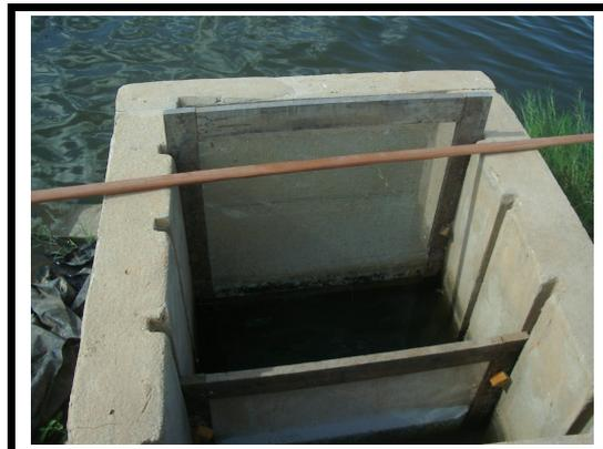
*Figura 34 – Caixa de distribuição de água.*
