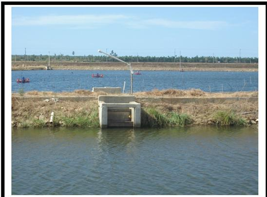
*Figura 33 – Ponto de distribuição de água.*
